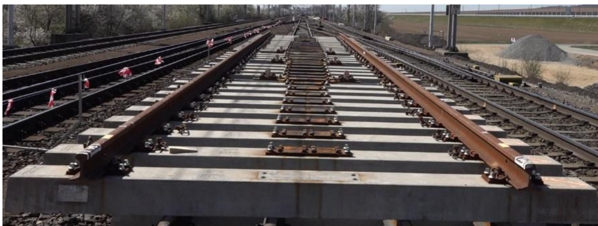
Obrázek 19 - Předmontáž srdcovkové části na nepojížděné koleji
