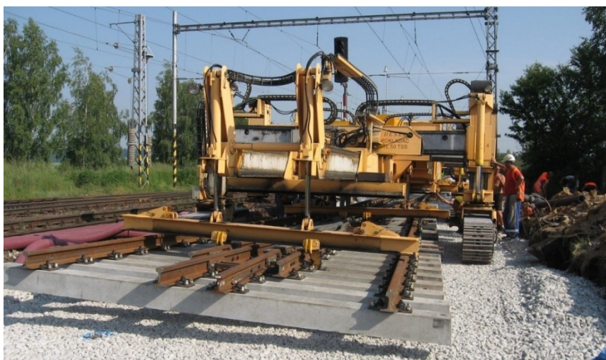
Obrázek 20 - Pokládka srdcovkové části pokladačem
