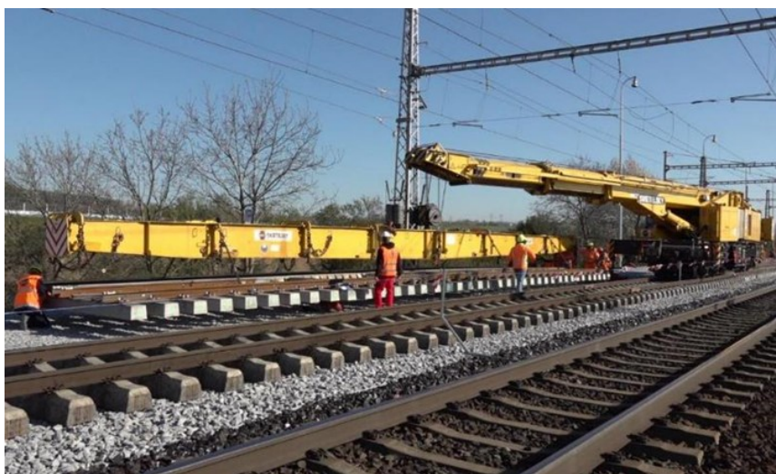
Obrázek 21 - Pokládka srdcovkové části kolejovým jeřábem
