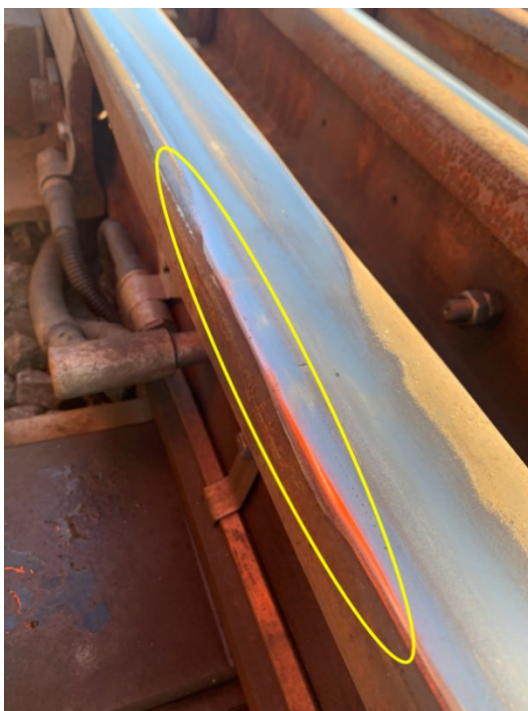
Obrázek 23 - Převalky na v oblasti dilatace hrotu
